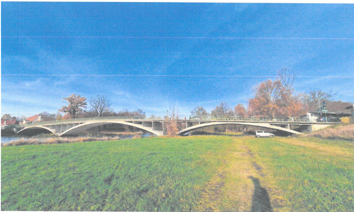
Fot. 1. Widok mostu od strony wody górnej
