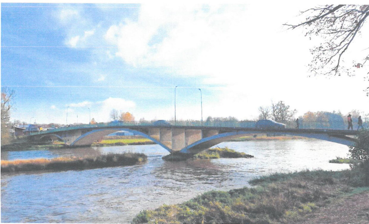
Fot. 2. Widok mostu od strony wody dolnej
