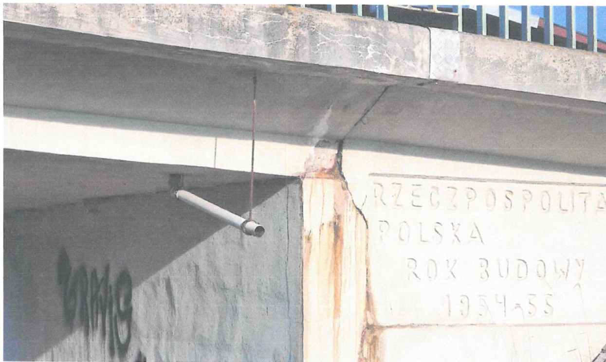
Fot. 15. Nieszczelność dylatacji i zacieki w strefie oparcie przęseł na przyczółkach, widoczna korozja betonu i jego ubytki
