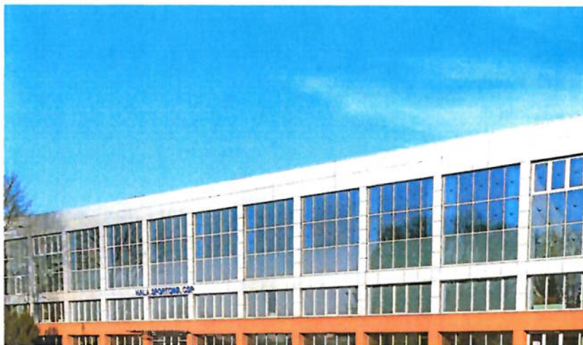
Fot. nr 1 budynek nr 42
