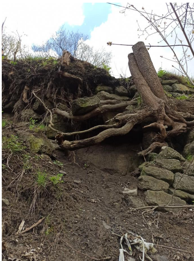
Fot. 4 Uszkodzenia skarpy w wyniku ruchów masowych
