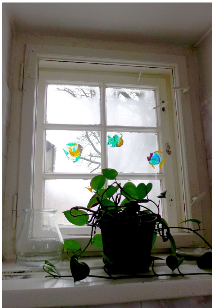
Fot. 46. Lidzbark Warmiński, Szkoła przy ul. Szkolnej 2, okno O10, widok ogólny na okno od strony wewnętrznej. Widoczne pierwotne obydwie skrzydła, brak klamki w skrzydle zewnętrznym oraz jedna wymieniona w skrzydle wewnętrznym.
