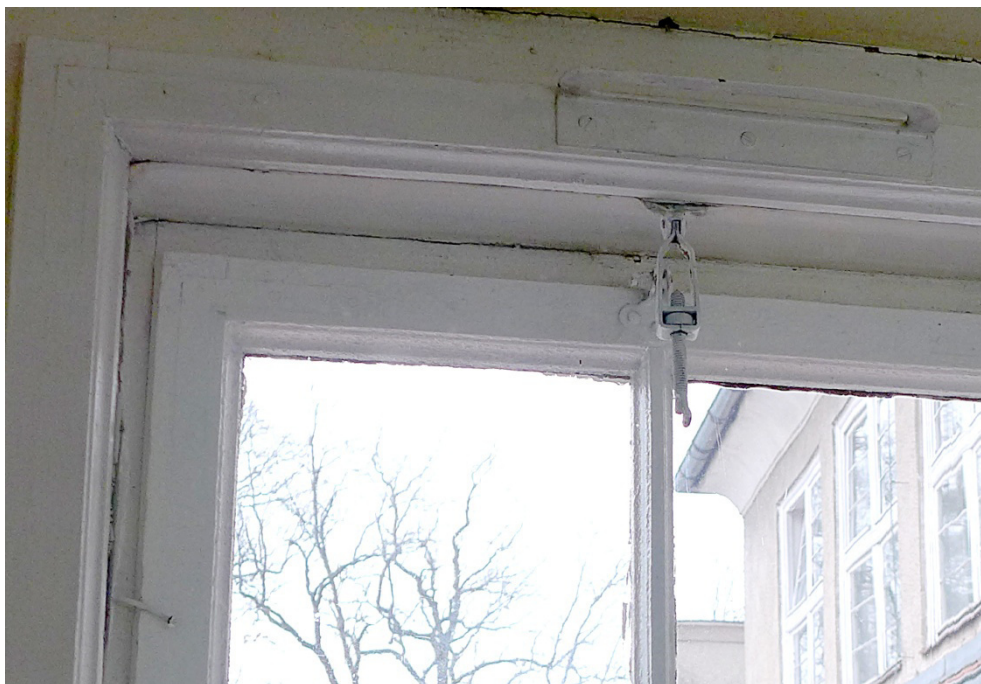
Fot. 44. Lidzbark Warmiński, Szkoła przy ul. Szkolnej 2, okno O9, zbliżenie pokazuje zachowany haczyk łączący obydwie skrzydła do uchyłu, natomiast brak mechanizmu, w górnej części blaszka i uszkodzona ościeżnica, widać, że skrzydła zewnętrzne domykają gwoździe.
