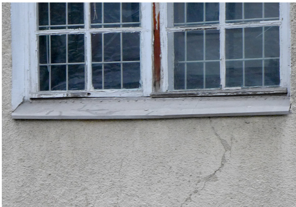
Fot. 47. Lidzbark Warmiński, Szkoła przy ul. Szkolnej 2, okno O12, zbliżenie pokazuje brak listwy przymykowej oraz dużego fragmentu okapnika.
