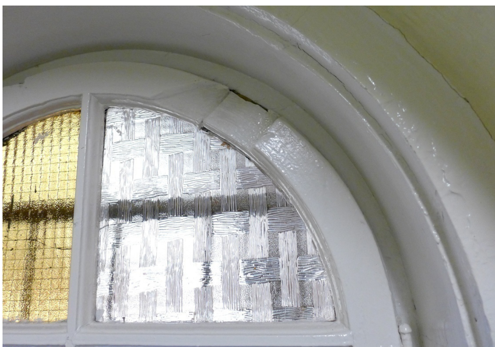
Fot. 50. Lidzbark Warmiński, Szkoła przy ul. Szkolnej 2, okno O12, zbliżenie pokazuje, ubytek mechaniczny ramy skrzydła zewnętrznego od strony wewnętrznej.
