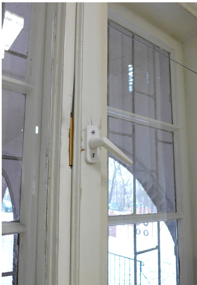
Fot. 39. Lidzbark Warmiński, Szkoła przy ul. Szkolnej 2, okno O6, zbliżenie pokazuje uszkodzenia ramiaków spowodowane wymianą zamka i klamki. W skrzydle wewnętrznych pęknięta szyba.
