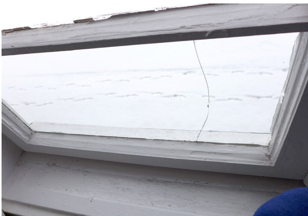
Fot. 3. Lidzbark Warmiński, Szkoła przy ul. Szkolnej 2, okno O1, zbliżenie pokazuje pękniętą szybę w wyniku naprężeń i wypaczenia skrzydła.
