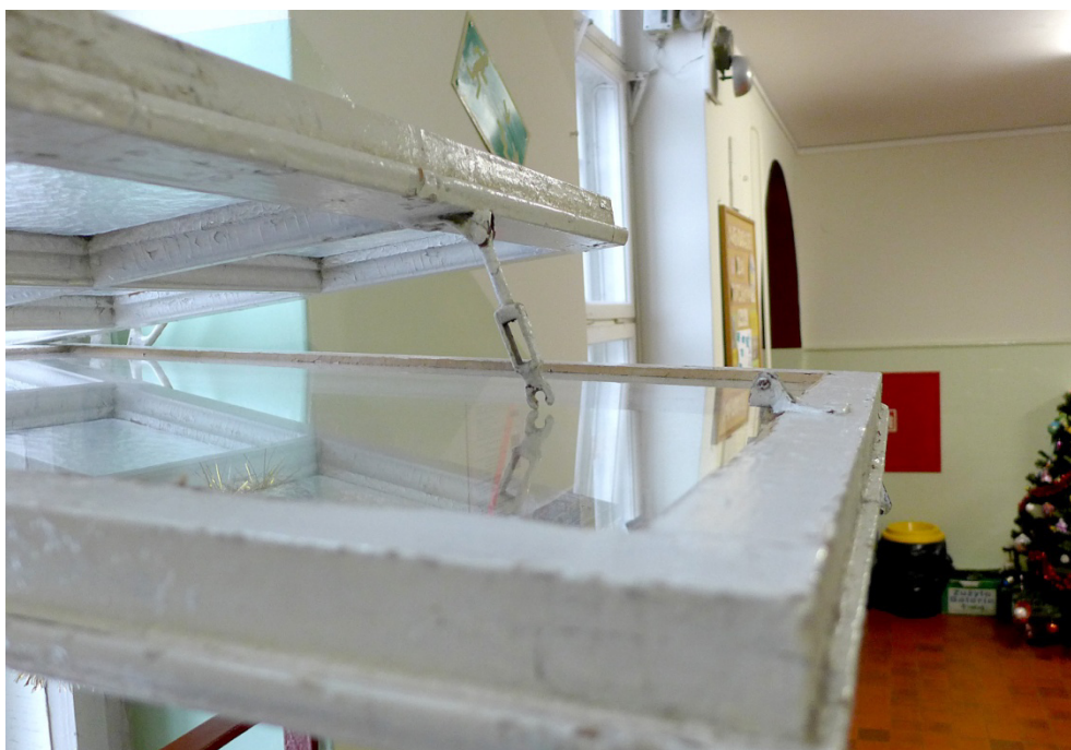
Fot. 53. Lidzbark Warmiński, Szkoła przy ul. Szkolnej 2, okno O14, zbliżenie pokazuje system mocowania skrzydła zewnętrznego z wewnętrznym do wspólnego uchytu.
