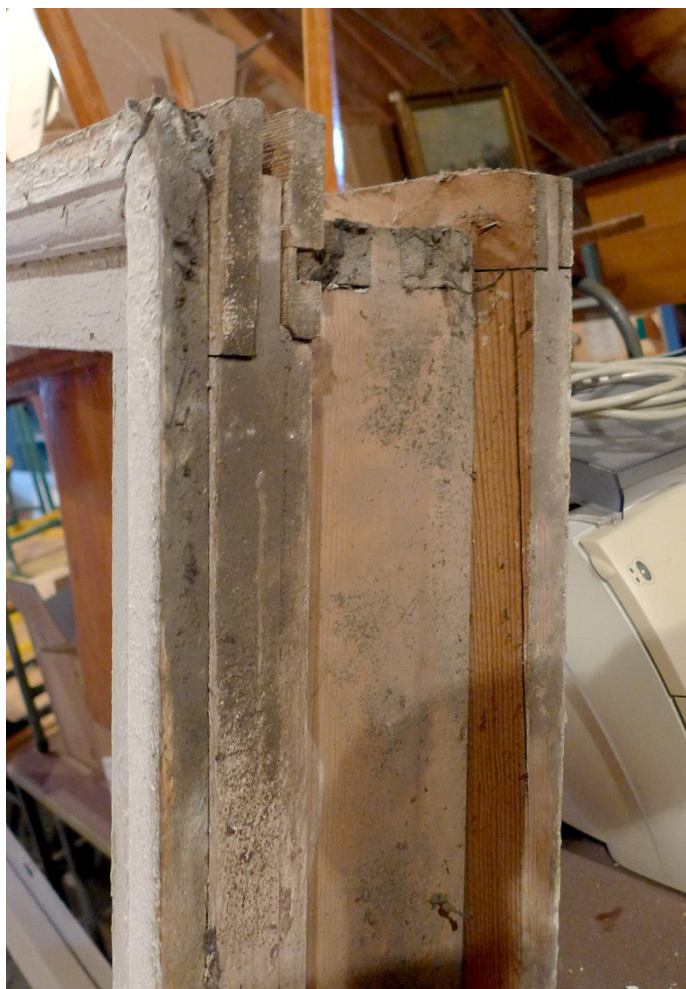
Fot. 63. Lidzbark Warmiński, Szkoła przy ul. Szkolnej 2, jedno ze zdemontowanych okien złożonych na strychu, widoczna konstrukcja oraz połączenia poszczególnych elementów. Od lewej widoczne listwy maskujące od zewnątrz styk ościeznicy z murem, następnie krosno zewnętrzne, pozorna skrzynka oraz krosno wewnętrzne.
