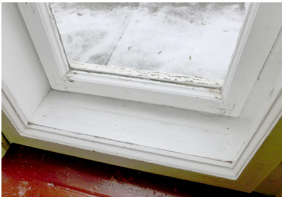
Fot. 60. Lidzbark Warmiński, Szkoła przy ul. Szkolnej 2, okno O15, zbliżenie pokazuje profile krawędzi ramiaków oraz wypłukany z warstw malarskich okapnik.
