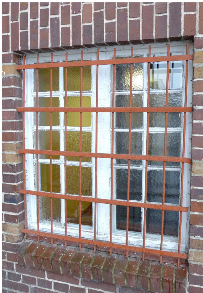
Fot. 26. Lidzbark Warmiński, Szkoła przy ul. Szkolnej 2, okno O3, widok ogólny na okno od strony zewnętrznej – wersja okna z listwami przymykowymi zamiast stałego słupka.
