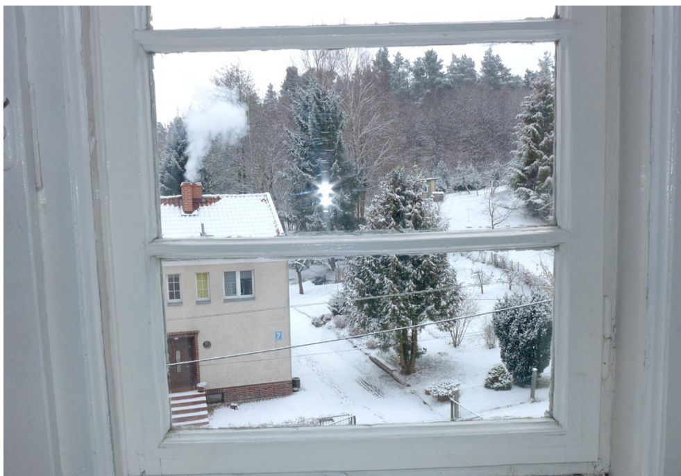
Fot. 6. Lidzbark Warmiński, Szkoła przy ul. Szkolnej 2, okno O1, zbliżenie pokazuje ugięcie szprosów, spowodowane złą kondycją kitów szklarskich i zaciekaniami wody opadowej.
