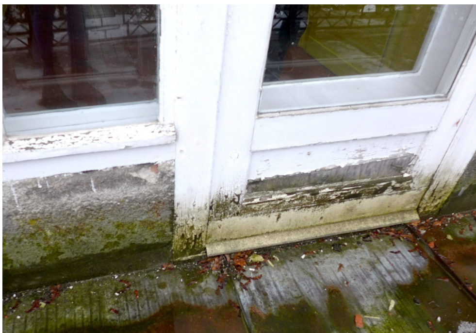
Fot. 61. Lidzbark Warmiński, Szkoła przy ul. Szkolnej 2, okno O15, zbliżenie pokazuje zawilgoconą i pokrytą wykwitami biologicznymi dolną część skrzydła drzwiowego. Sytuacja ta ma miejsce przez wzgląd na niewyprofilowaną posadzkę balkonu, która nie odprowadza wody.
