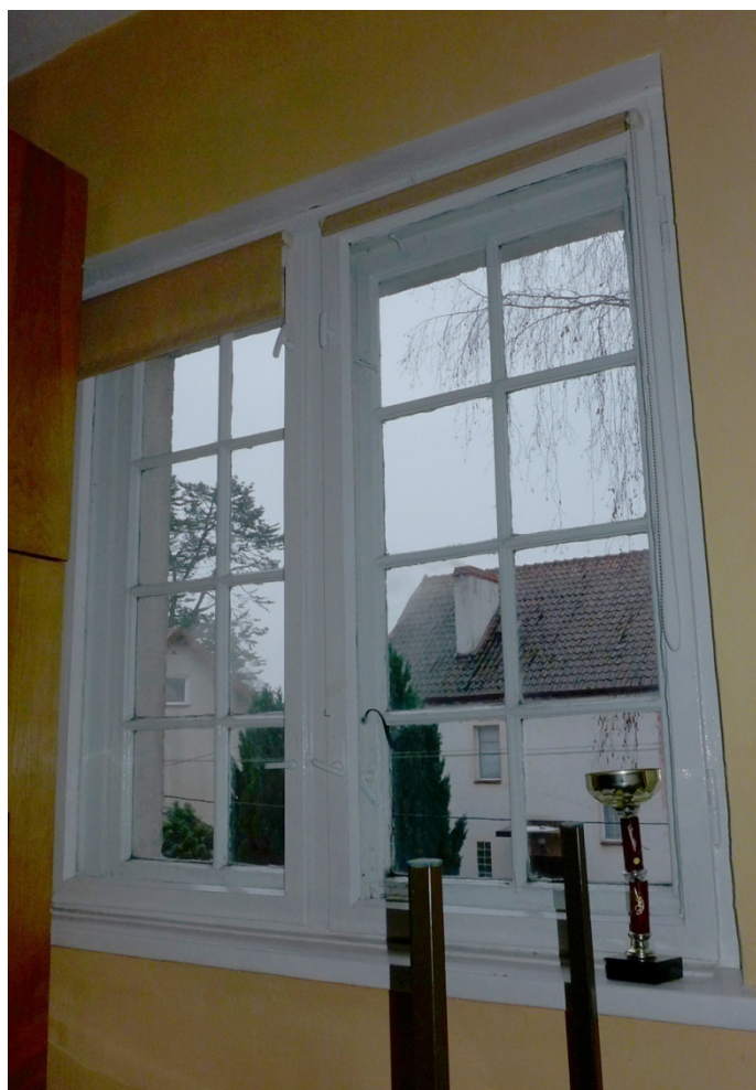
Fot. 23. Lidzbark Warmiński, Szkoła przy ul. Szkolnej 2, okno O3, widok ogólny od strony wewnętrznej. Okno ze stałym słupkiem, każde skrzydło zamykane na dwie klamki jednoramienne, skrzydła wewnętrzne wtórne.
