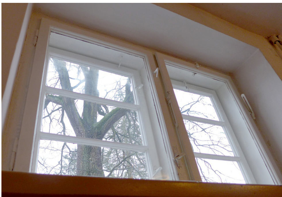
Fot. 41. Lidzbark Warmiński, Szkoła przy ul. Szkolnej 2, okno O8, widok ogólny od strony wewnętrznej. Widoczne klamki jednoramienne, po dwie na skrzydło oraz system uchyłu.
