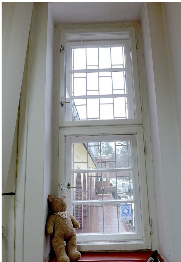
Fot. 40. Lidzbark Warmiński, Szkoła przy ul. Szkolnej 2, okno O7, widok ogólny od strony wewnętrznej. Szyba w górnym skrzydle wewnętrznym jest spękana w dwóch miejscach w wyniku naprężeń drewna i wypaczenia skrzydeł.
