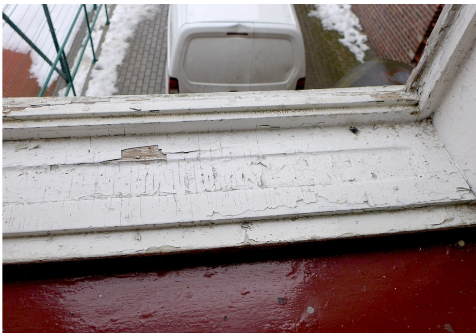
Fot. 56. Lidzbark Warmiński, Szkoła przy ul. Szkolnej 2, okno O14, zbliżenie pokazuje spękanie i łuszczące się warstwy malarskie na dolnej ramie ościeżnicy.
