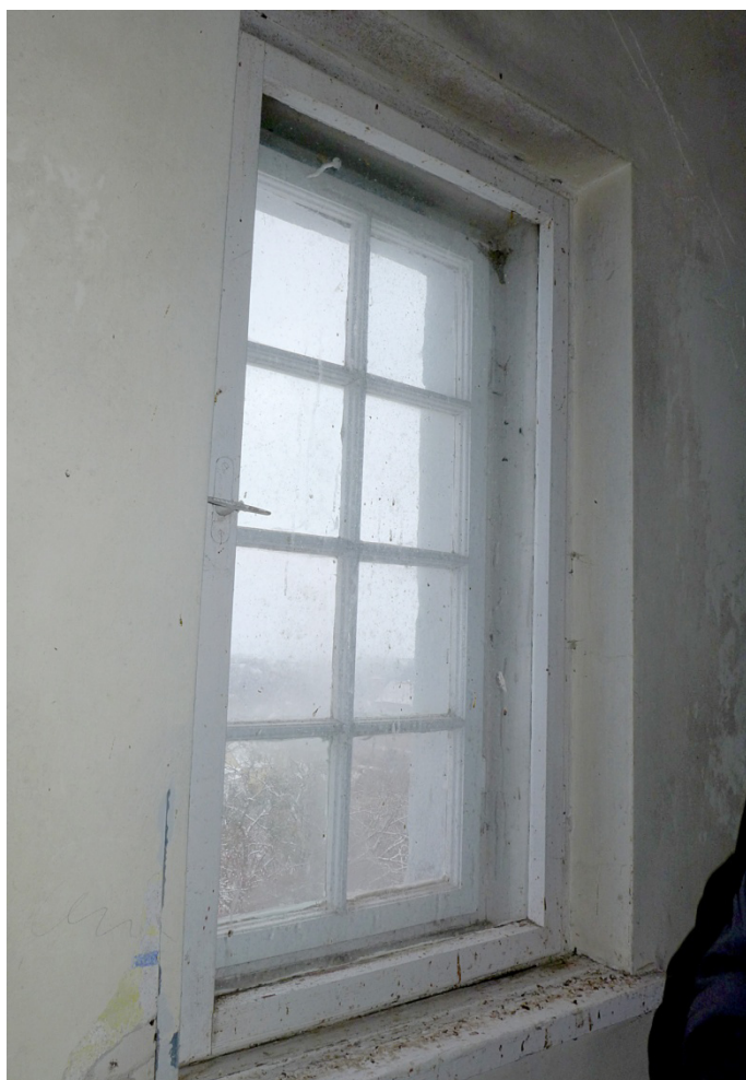
Fot. 37. Lidzbark Warmiński, Szkoła przy ul. Szkolnej 2, okno O5, widok ogólny na okno O5A ustawione za węgarkiem, widoczne wtórne wewnętrzne skrzydło z klamką równoramienną ze znanu.
