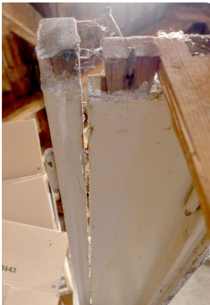
Fot. 64. Lidzbark Warmiński, Szkoła przy ul. Szkolnej 2, jedno ze zdemontowanych okien złożonych na strychu, widoczna konstrukcja oraz połączenia poszczególnych elementów. Widoczne rozwarstwienie krosna od pozornej skrzynki oraz forma połączenia skrzynki na jaskółczy ogon.
