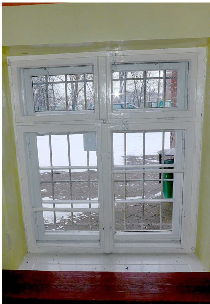
Fot. 13. Lidzbark Warmiński, Szkoła przy ul. Szkolnej 2, okno O2, widok ogólny. Okno z połączonymi skrzydłami w nadślemieniu, udawające dwa skrzydła z listwą przymykową. Zdemontowana dźwignia uchylu.
