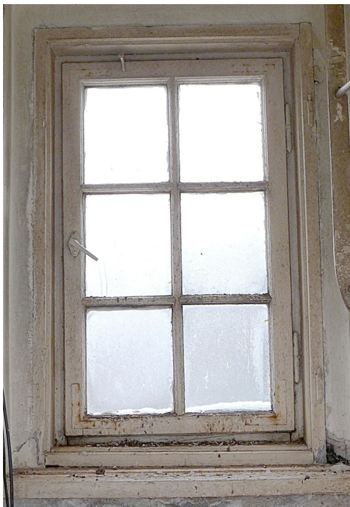
Fot. 35. Lidzbark Warmiński, Szkoła przy ul. Szkolnej 2, okno O5, widok ogólny na okno od strony wewnętrznej. Widoczne zawilgocenie dolnej partii okna co ujawnia się korozją metalowych kątowników.
