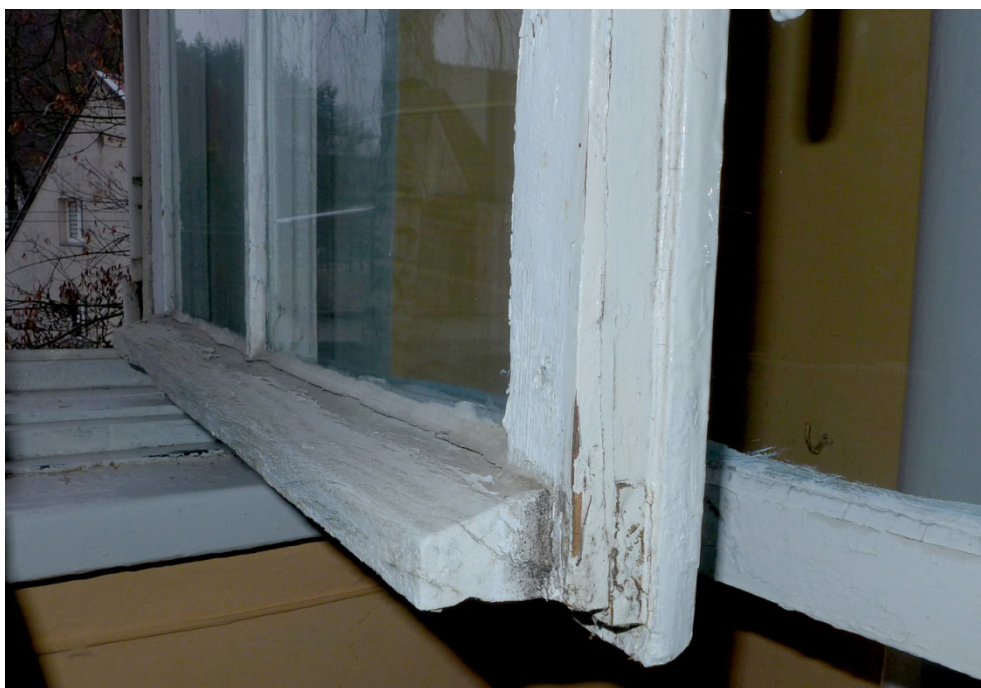
Fot. 21. Lidzbark Warmiński, Szkoła przy ul. Szkolnej 2, okno O3, zbliżenie pokazuje formę okapnika oraz bieżącą konserwację polegającą na uszczelnieniu silikonem.
