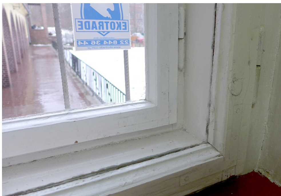
Fot. 38. Lidzbark Warmiński, Szkoła przy ul. Szkolnej 2, okno O6, zbliżenie pokazuje zawiasy czopowe oraz profile ramiaków oraz formę blaszek kątowych.
