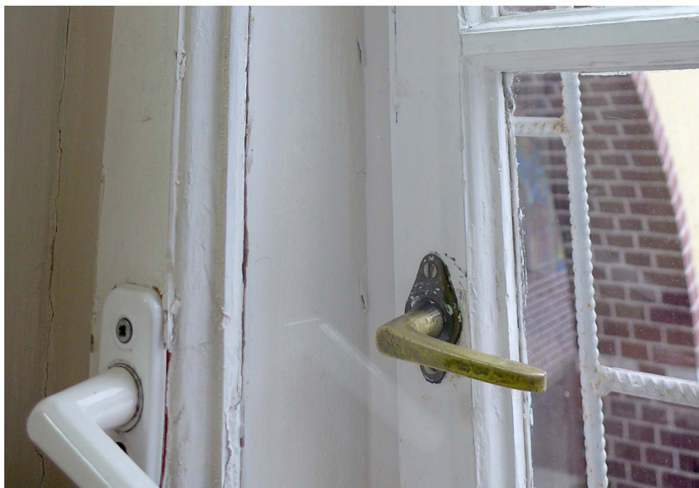
Fot. 39. Lidzbark Warmiński, Szkoła przy ul. Szkolnej 2, okno 07, zbliżenie pokazuje wtórny klamkę w skrzydle wewnętrznym oraz pierwotną jednoramienną w skrzydle zewnętrznym.
