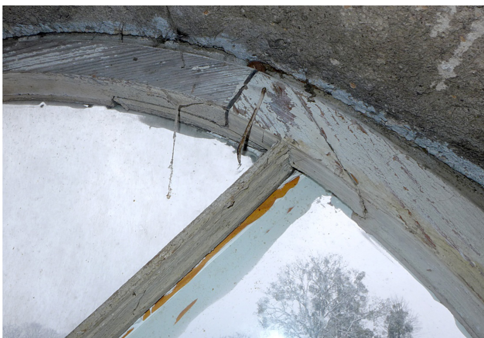
Fot. 30. Lidzbark Warmiński, Szkoła przy ul. Szkolnej 2, okno O4, zbliżenie pokazuje rozluźnienie połączeń ramiaka.
