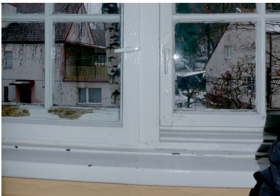
Fot. 25. Lidzbark Warmiński, Szkoła przy ul. Szkolnej 2, okno O3, zbliżenie pokazuje szeroki stały słupek oraz pierwotny parapet z lastrico wielokrotnie zamalowywany farbą olejną.
