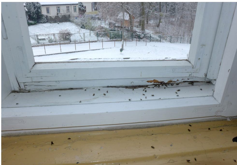
Fot. 4. Lidzbark Warmiński, Szkoła przy ul. Szkolnej 2, wtórne okno w typie okno O1, zbliżenie pokazuje mocno zawilgocone i zbutwiałe drewno dolnej części okna.
