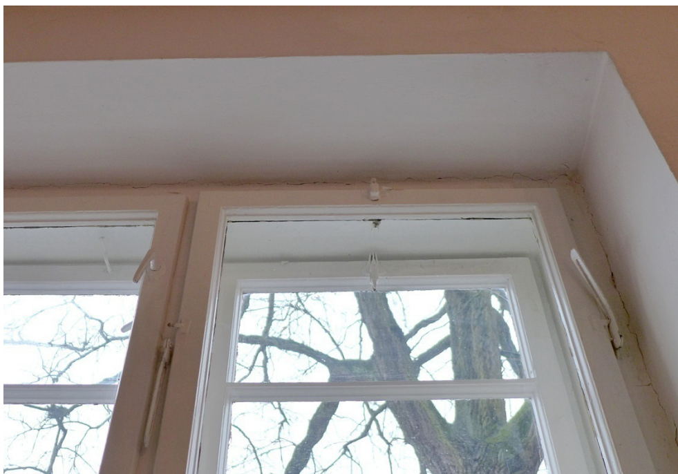
Fot. 42. Lidzbark Warmiński, Szkoła przy ul. Szkolnej 2, okno O8, zbliżenie pokazuje zdemonstrowaną dźwignię od systemu uchyłu, zamocowano wtórne zamknięcia w górnych ramiakach.
