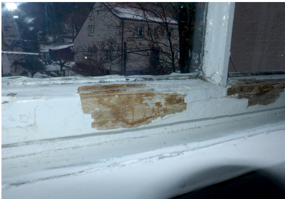
Fot. 22. Lidzbark Warmiński, Szkoła przy ul. Szkolnej 2, okno O3, zbliżenie pokazuje zawilgocony dolny ramiak skrzydła, warstwy malarskie odspajają się od podłoża.
