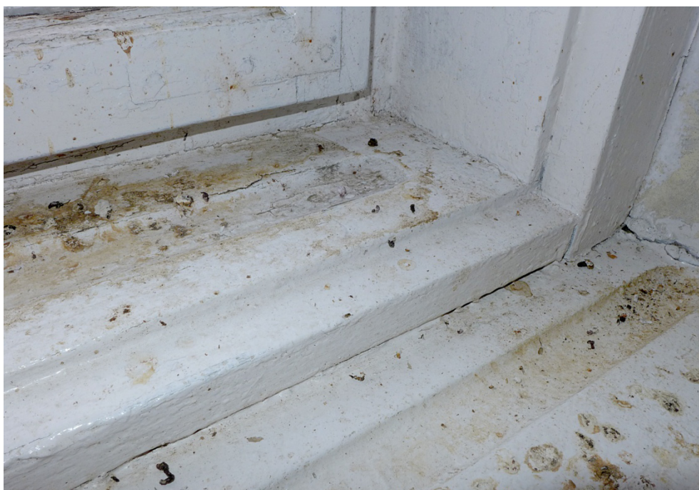
Fot. 33. Lidzbark Warmiński, Szkoła przy ul. Szkolnej 2, okno O5, zbliżenie pokazuje wodę opadową dostającą się na powierzchnię ościeżnicy i parapetu oraz ptasie ekskrementy.
