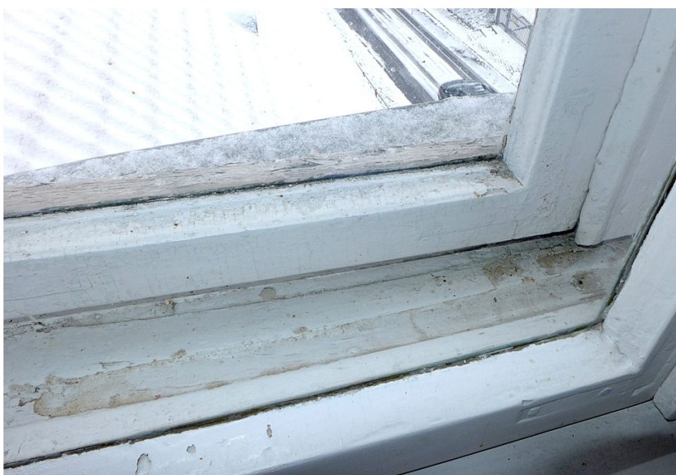
Fot. 16. Lidzbark Warmiński, Szkoła przy ul. Szkolnej 2, okno O2, zbliżenie pokazuje zaciekanie wody opadowej na dolną ramę ościeżnicy. Zacieki wynikają z wypaczenia skrzydeł co powoduje brak możliwości domknięcia skrzydeł.
