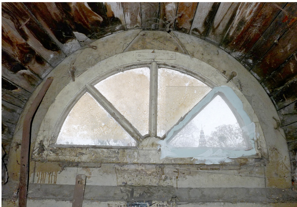
Fot. 31. Lidzbark Warmiński, Szkoła przy ul. Szkolnej 2, okno O4, zbliżenie pokazuje nieestetyczną wymianę szklenia jednej z kwater, w oknie brak jednej zakrętki i fragmentu klina ramy w górnej części.
