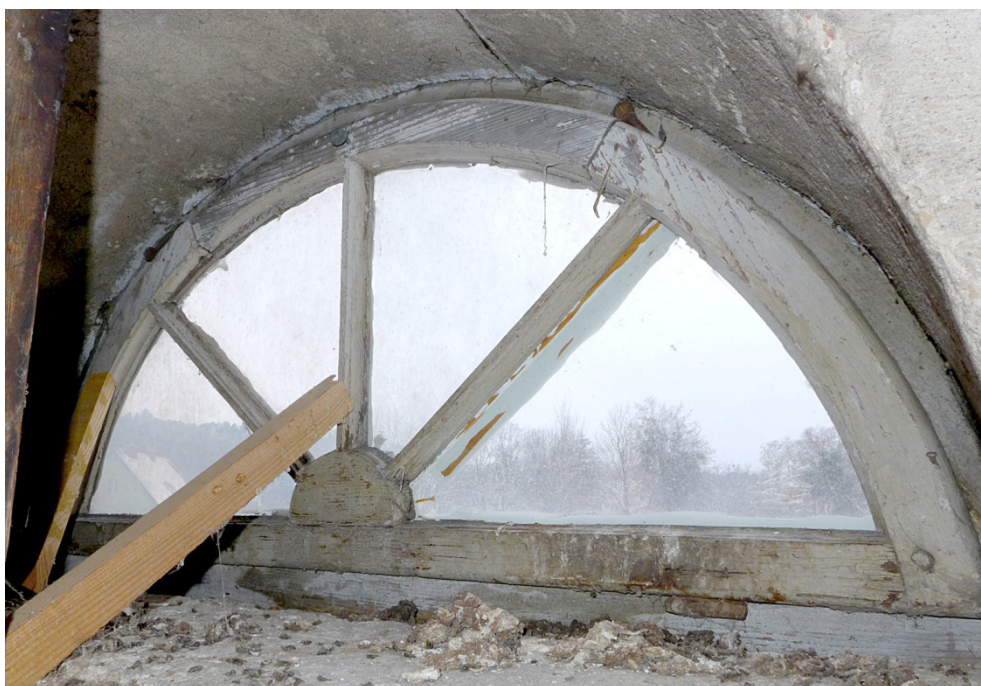
Fot. 28. Lidzbark Warmiński, Szkoła przy ul. Szkolnej 2, okno O4, widok ogólny, czytelne kołki w połączeniu narożników. Brak części zawiasów i zakrętki.
