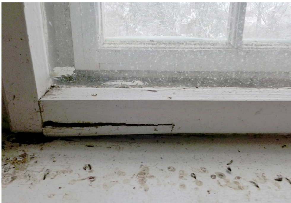
Fot. 32. Lidzbark Warmiński, Szkoła przy ul. Szkolnej 2, okno O5, zbliżenie pokazuje uszkodzenie mechaniczne ramiaka skrzydła wewnętrznego.
