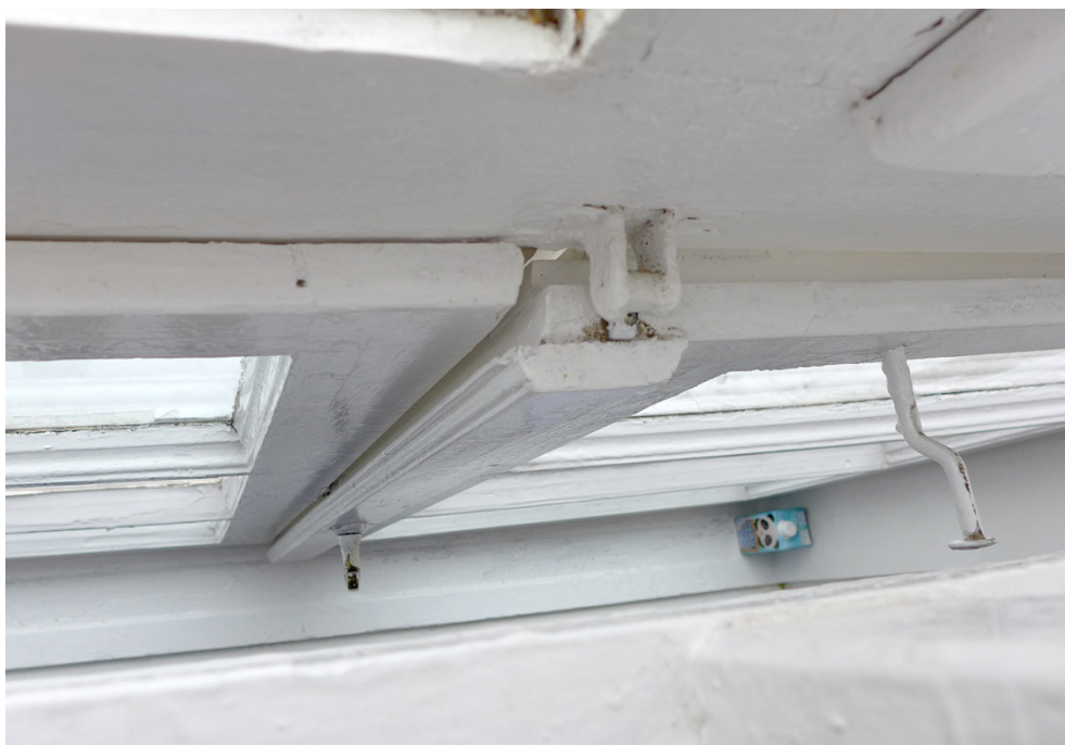
Fot. 12. Lidzbark Warmiński, Szkoła przy ul. Szkolnej 2, okno O1, zbliżenie pokazuje duże wypaczenie skrzydła podślemienia, które uniemożliwia poprawne zamknięcie skrzydła.
