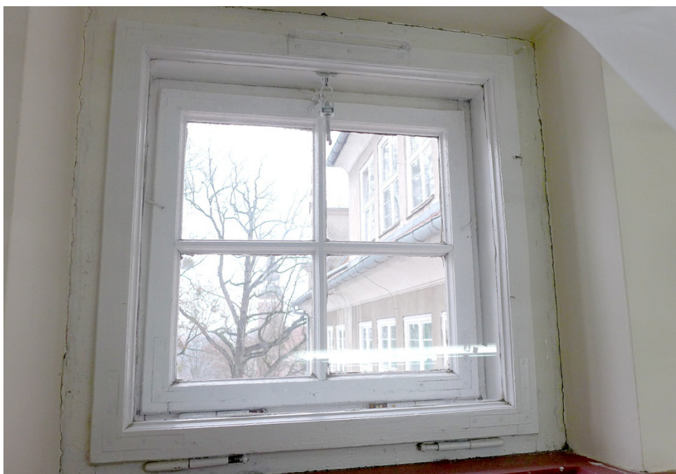
Fot. 43. Lidzbark Warmiński, Szkoła przy ul. Szkolnej 2, okno O9, widok ogólny na okno od strony wewnętrznej. Widoczne zachowany obydwie skrzydła. Uszkodzone zawiasy, trzpienie powypychane.
