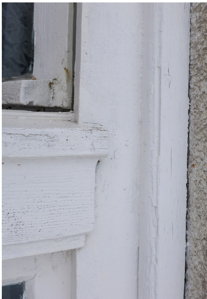
Fot. 8. Lidzbark Warmiński, Szkoła przy ul. Szkolnej 2, okno O1, zbliżenie pokazuje profil ślemienia oraz profil listwy maskującej styk ościeżnicy z murem.
