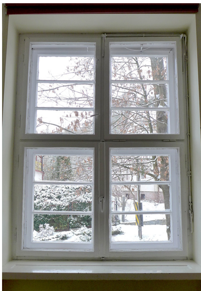
Fot. 7. Lidzbark Warmiński, Szkoła przy ul. Szkolnej 2, okno O1, widok ogólny na okno od strony wewnętrznej. Widoczne uchylne prawe skrzydło nadświetlenia wraz z systemem uchylu, uchylającym jednocześnie obydwa skrzydła.
