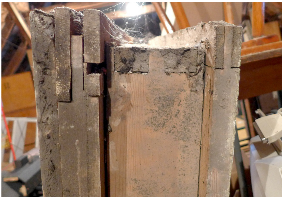
Fot. 62. Lidzbark Warmiński, Szkoła przy ul. Szkolnej 2, jedno ze zdemontowanych okien złożonych na strychu, widoczna konstrukcja oraz połączenia poszczególnych elementów. Pomiędzy dwoma krosnami znajduje się pozorna skrzynka.
