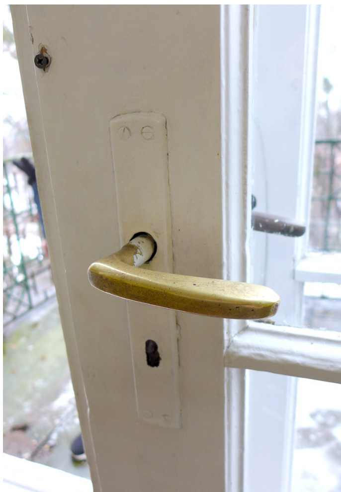
Fot. 59. Lidzbark Warmiński, Szkoła przy ul. Szkolnej 2, okno O15, zbliżenie pokazuje zachowaną klamkę drzwiową z wtórnym szyldem. Pierwotny szyld w formie łezki widoczny częściowo w skrzydle zewnętrznym.
