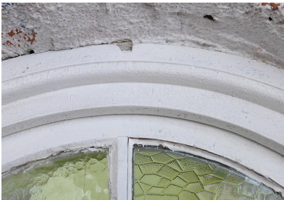
Fot. 48. Lidzbark Warmiński, Szkoła przy ul. Szkolnej 2, okno O12, zbliżenie pokazuje, wydatną ościeżnicę z profilowaną listwą maskującą styk ościeżnicy z murem.
