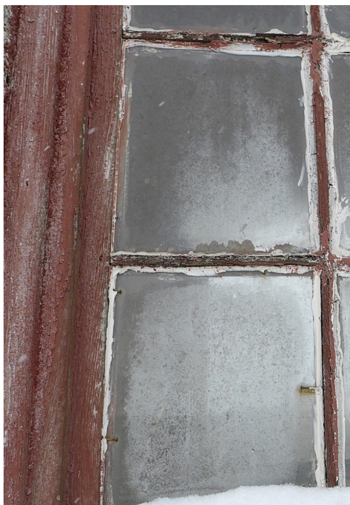
Fot. 34. Lidzbark Warmiński, Szkoła przy ul. Szkolnej 2, okno O5, zbliżenie pokazuje całkowitą destrukcję szprosów, mocowanie szyb białym silikonem oraz widoczny profil listwy maskującej.
