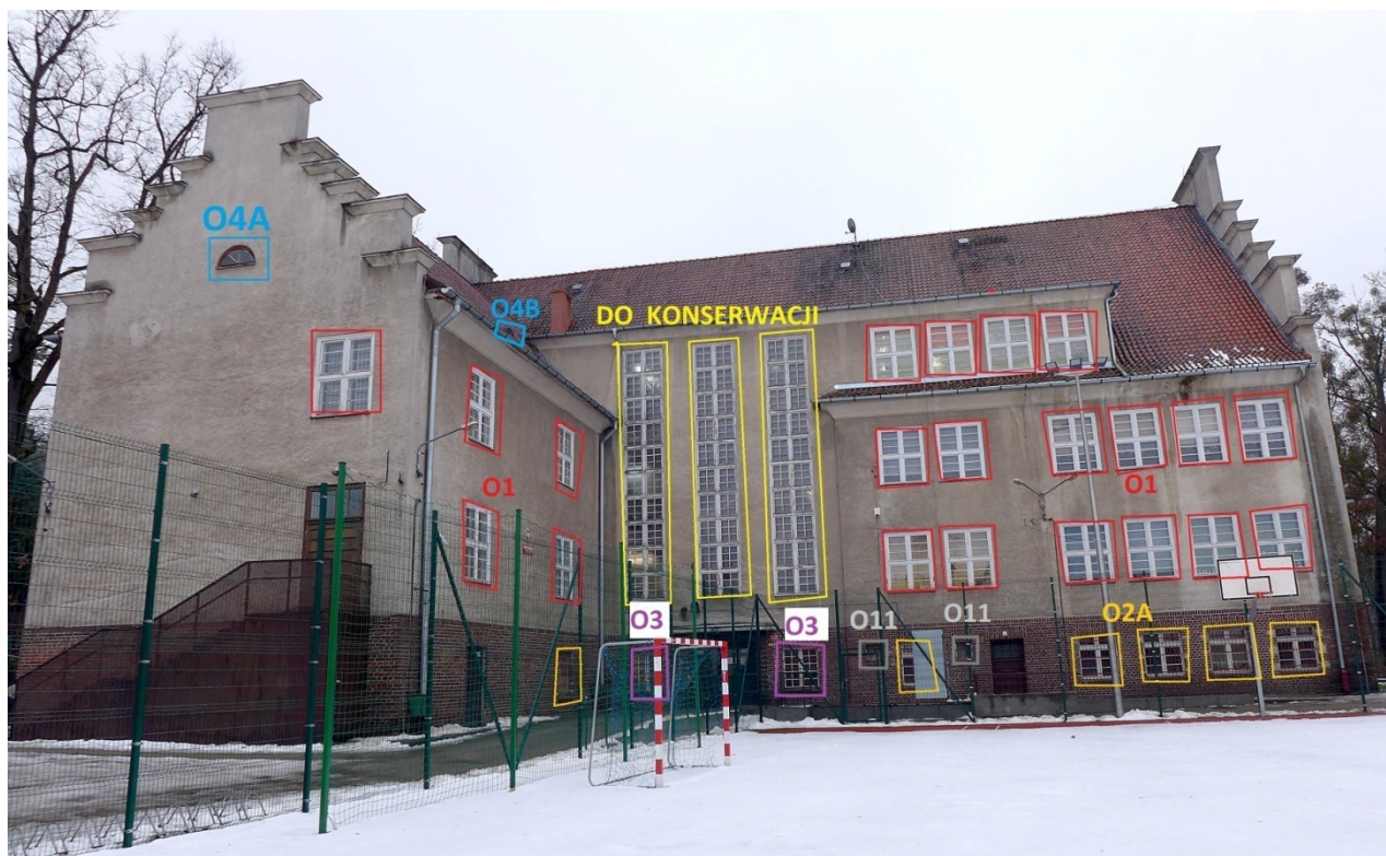
Fot. 7. Lidzbark Warmiński, ul. Szkolna 2. Rozpoznanie typów stolarki okiennej. Zaznaczono trzy okna termometry, które należy przeznaczyć do konserwacji.
