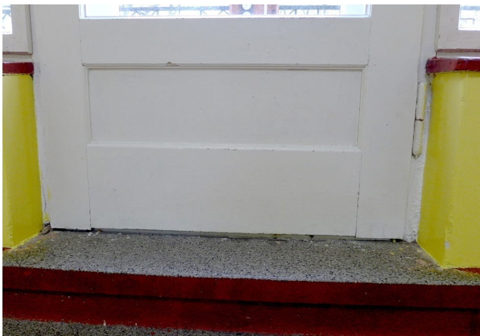
Fot. 57. Lidzbark Warmiński, Szkoła przy ul. Szkolnej 2, okno O15, zbliżenie pokazuje dolną kwaterę pełną w układzie poziomym oraz profile krawędzi ramiaków.
