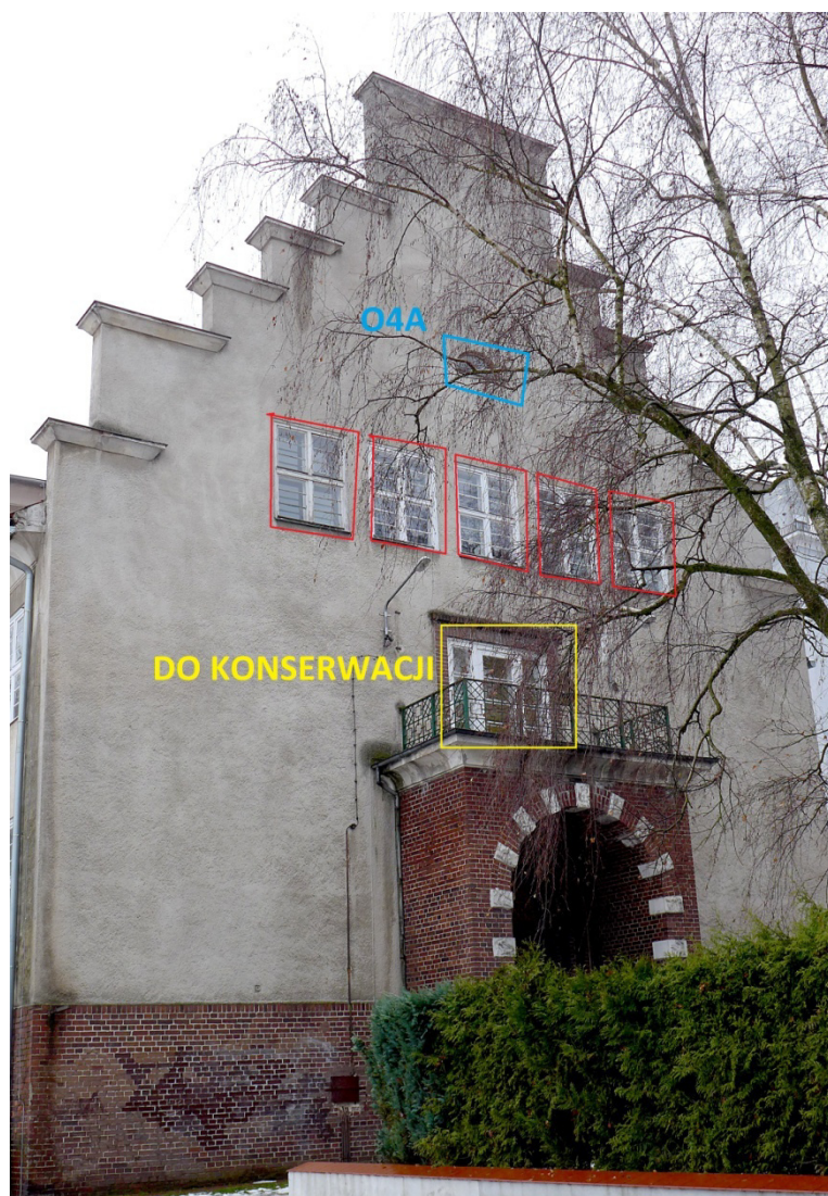
Fot. 6. Lidzbark Warmiński, ul. Szkolna 2. Rozpoznanie typów stolarki okiennej. Zaznaczono zestaw z drzwiami balkonowymi, które należy przeznaczyć do konserwacji.
