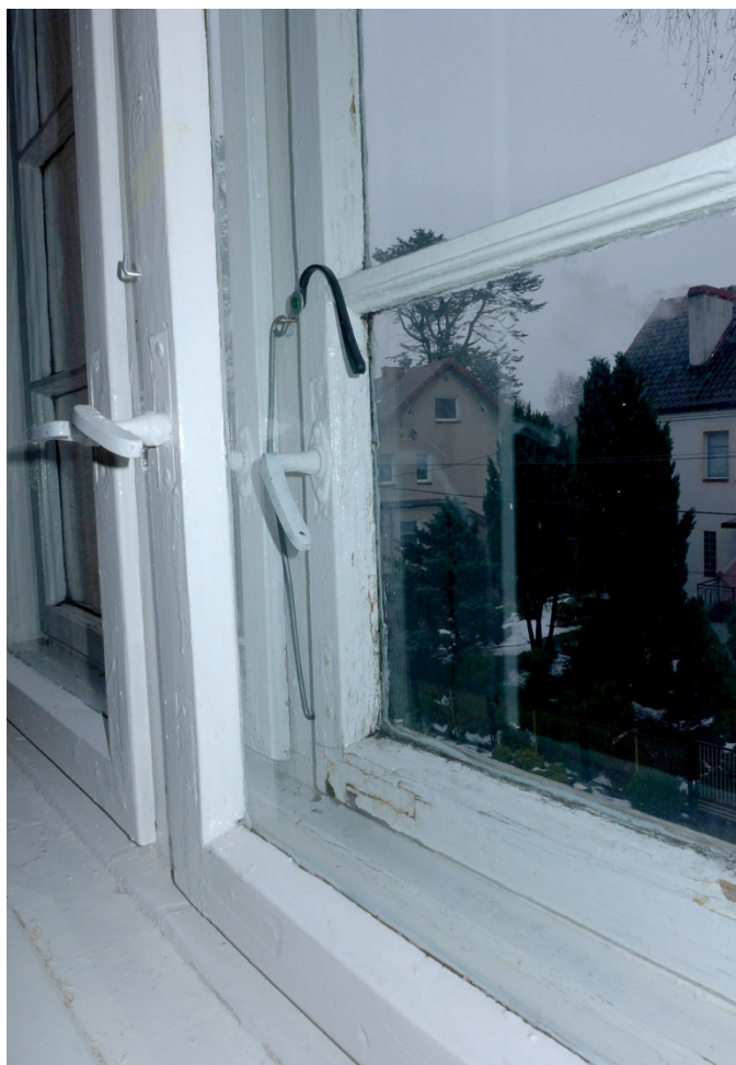
Fot. 24. Lidzbark Warmiński, Szkoła przy ul. Szkolnej 2, okno O3, zbliżenie pokazuje formę pierwotnych klamek w skrzydłach zewnętrznych. Widoczne także wtórne skrzydła wewnętrzne – ramiaki bez profilowań.
