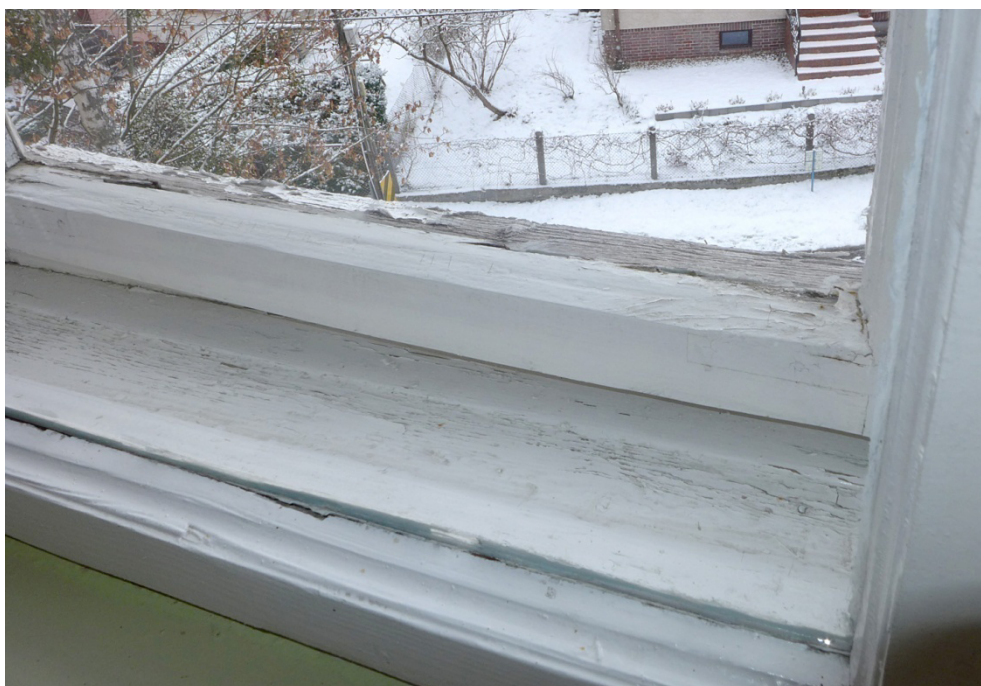
Fot. 1. Lidzbark Warmiński, Szkoła przy ul. Szkolnej 2, okno O1, zbliżenie pokazuje zawilgoconą dolną część ościeżnicy od, której odpajają się warstwy malarskie.
