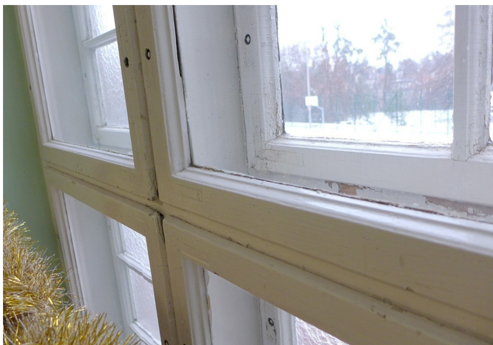
Fot. 55. Lidzbark Warmiński, Szkoła przy ul. Szkolnej 2, okno O14, zbliżenie pokazuje profile krawędzi ramiaków, łuszczące się warstwy malarskie i drobne ubytki mechaniczne przy szybach.
