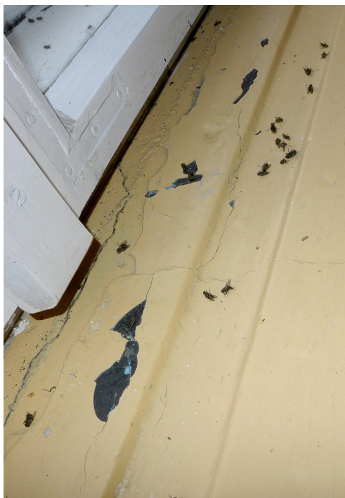
Fot. 5. Lidzbark Warmiński, Szkoła przy ul. Szkolnej 2, okno O1, zbliżenie pokazuje spękany w masie parapet z lastrico, wielokrotnie przemalowany farbami olejnymi.
