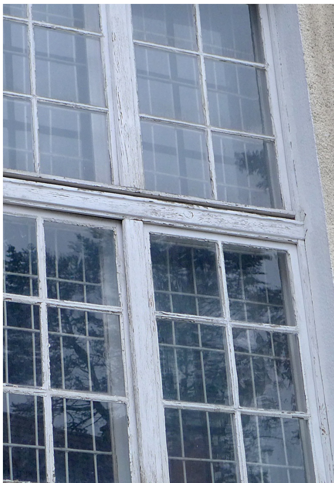
Fot. 48. Lidzbark Warmiński, Szkoła przy ul. Szkolnej 2, okno O12, zbliżenie pokazuje niedomykające się skrzydło po lewej stronie zdjęcia. Wypłukane warstwy malarskie, ubytki i spękania kitów szklarskich.
