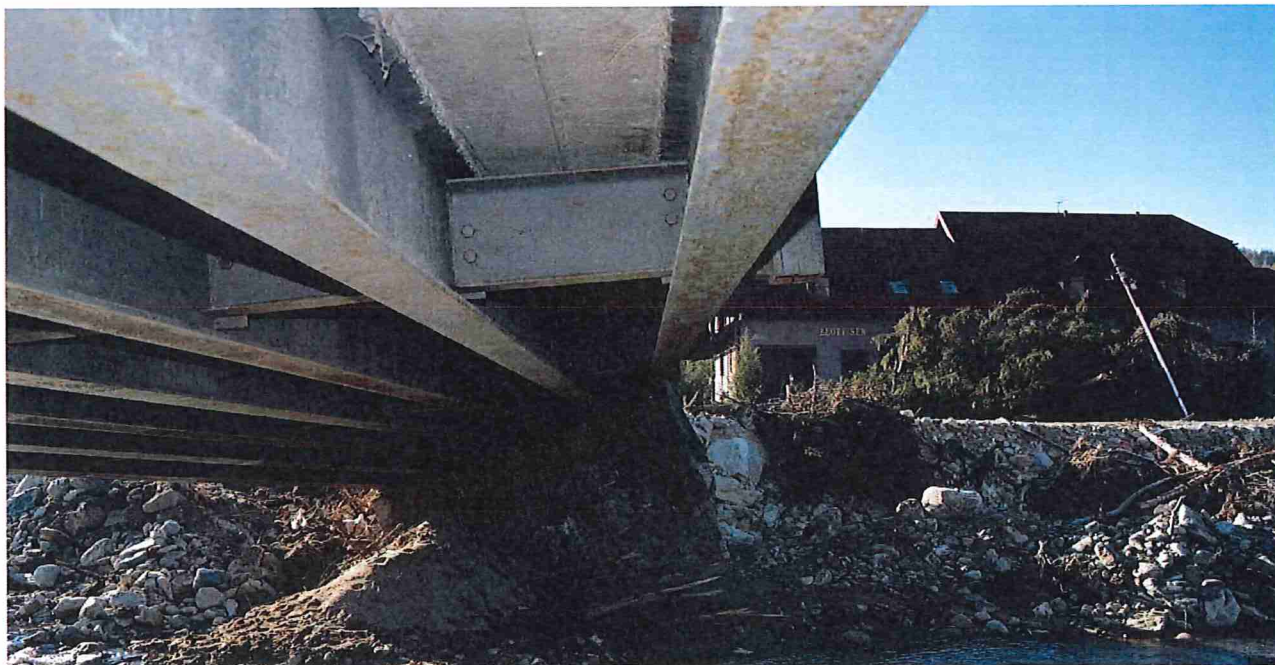
Rys. 1.2 Widok na osiadłą podporę mostu i skrzycone przęsło
