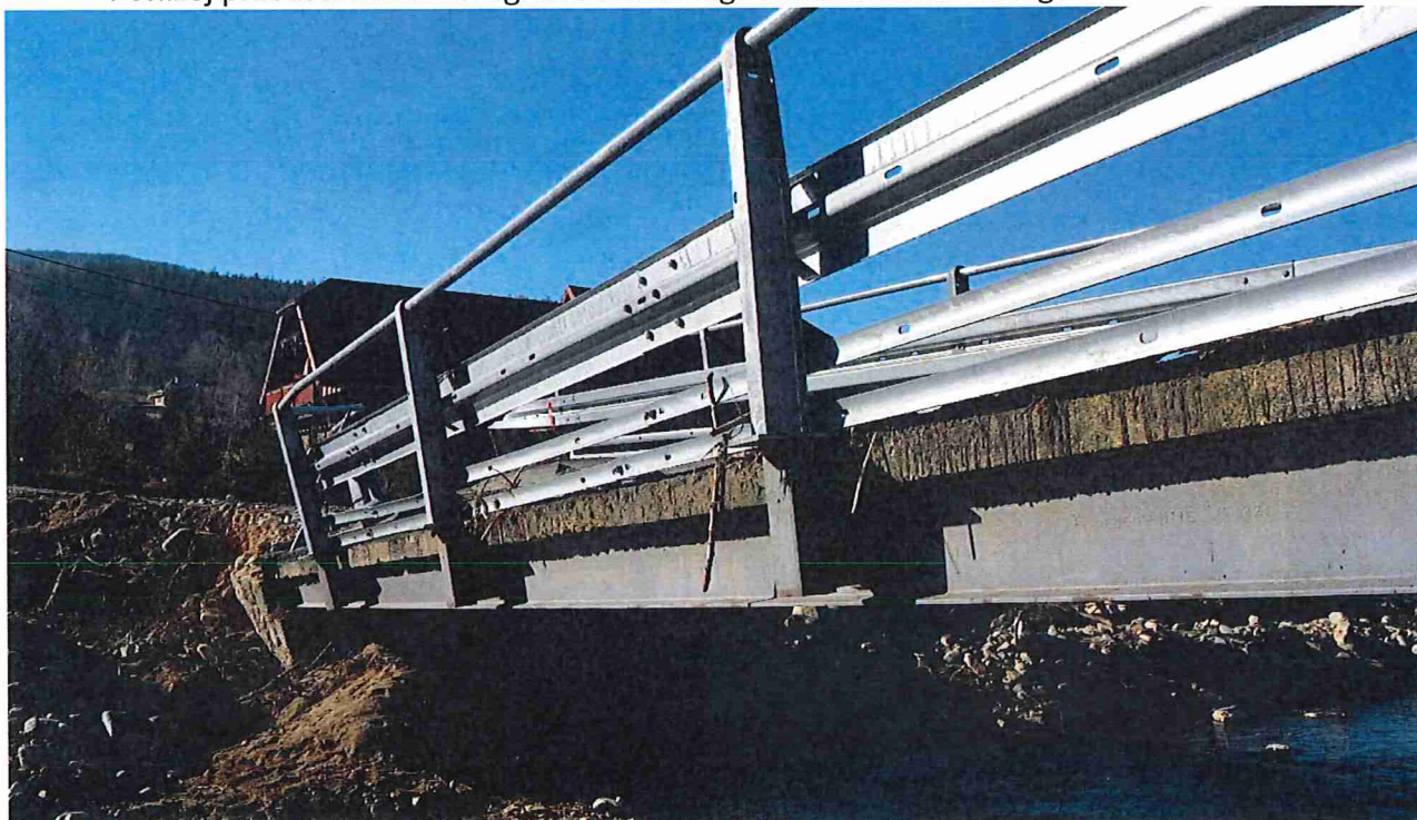
Rys. 3.1 Widok na most i uszkodzony przyczółek
