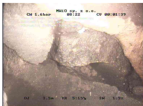
24b1577e-5530-496b-849c-2fea97531c55_20241031_082954_207.jpg, 00:01:04, 3.86 Rezygnacja z inspekcji, przeszkoda
