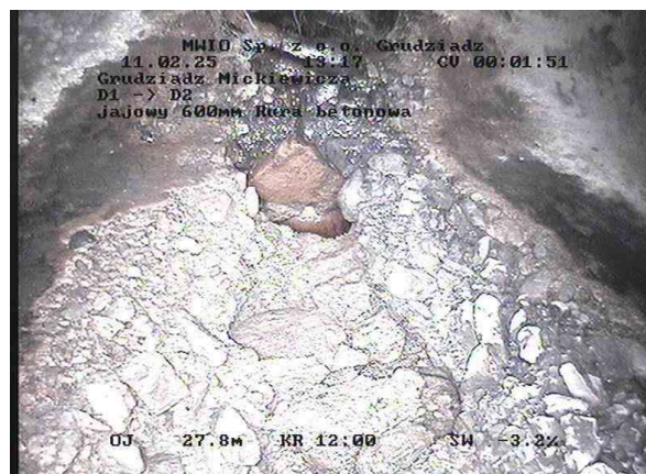
8a9d1e74-c6ef-47b1-aaf9-fc277e755e43_20250211_131606_613.jpg, 00:01:42, 27.85m Przerwanie, brakujące fragmenty ściany przy 2 godz.
