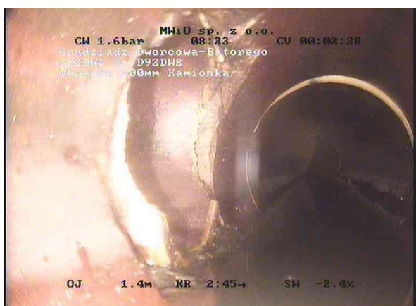
f60601ed-2e47-414d-8a9c-e2d6e56b88ec_20241031_083054_221.jpg, 00:02:12, 1.71 Połączenie, łącznik, przyłączy otwarte, 150mm wysoki przy 9
