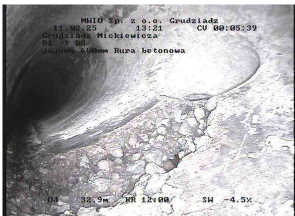
23c44af9-50df-4ae7-b22b-c15b41b2f730_20250211_132036_140.jpg, 00:05:04, 32.94m Połączenie, łącznik, przyłącze otwarte, 150mm wysoki przy 2 godz.
