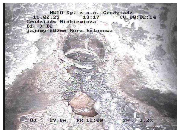
86cc8f15-7d40-4be3-b54c-0bf133857330_20250211_131643_402.jpg, 00:01:59, 27.85m Połączenie, łącznik, przyłącze otwarte, 150mm wysoki przy 1 godz.
