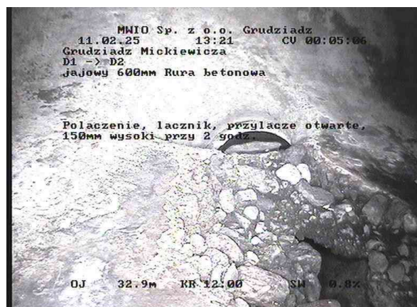
6e1943f3-42c3-407f-adac-63ee17f1d061_20250211_132003_163.jpg, 00:05:04, 32.94m Połączenie, łącznik, przyłącze otwarte, 150mm wysoki przy 2 godz.
