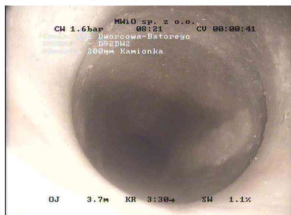
cb0a8cec-ea30-4258-b668-747e7b0a7b01_20241031_082834_617.jpg, 00:00:36, 3.70 Połączenie, proste połączenie - wydłutowane, otwarte,
