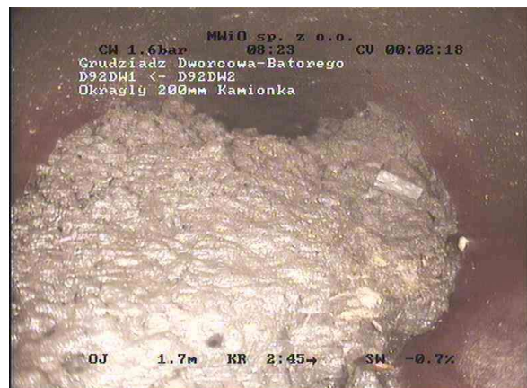
1c4fe397-a264-44b6-8c14-c534553b933b_20241031_083045_025.jpg, 00:02:12, 1.71 Połączenie, łącznik, przyłączy otwarte, 150mm wysoki przy 9
