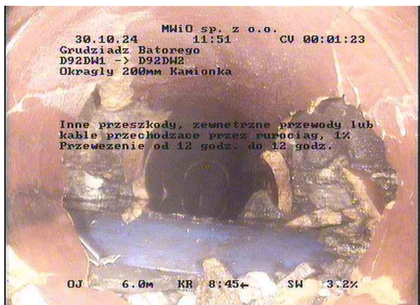
1c4577cc-7ca0-412d-8b92-074d2baa3c88_20241030_115740_283.jpg, 00:01:19, 6.04 Inne przeszkody, zewnętrzne przewody lub kable
