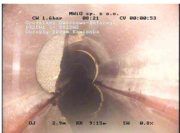
1758a46a-b604-4b03-840a-808c85fe88d8_20241031_082846_503.jpg, 00:00:36, 3.70 Połączenie, proste połączenie - wydłutowane, otwarte,
