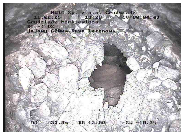
d9dcd0d8-e075-49e0-98b1-39487b22b805_20250211_131927_850.jpg, 00:04:35, 32.85m Przerwanie, brakujące fragmenty ściany, Długość: 20mm przy 3 godz.
