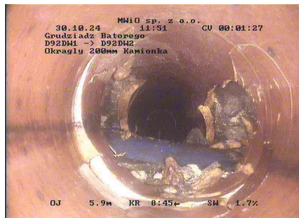
acf15bcc-5446-4d34-b7ec-9ba2d8307db1_20241030_115744_410.jpg, 00:01:19, 6.04 Inne przeszkody, zewnętrzne przewody lub kable
