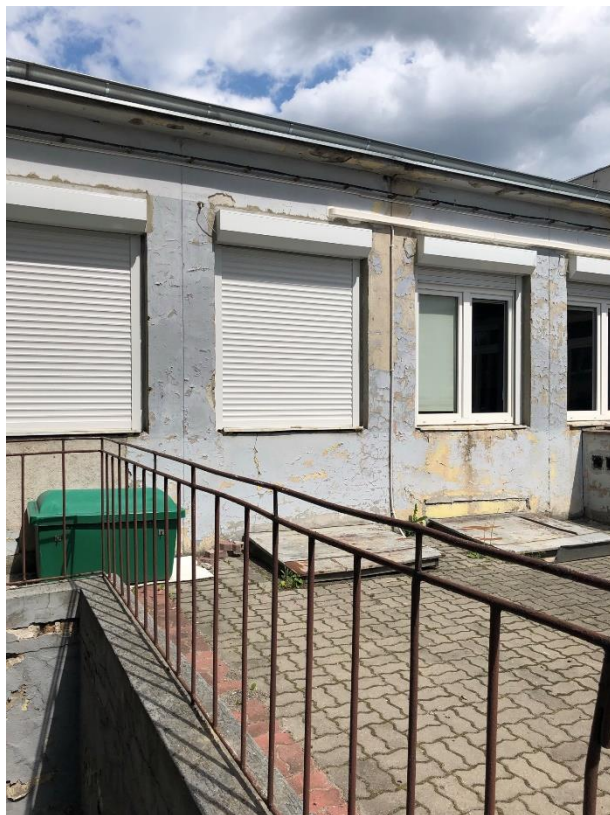
Ubytki tynku i farby na elewacji łącznika
