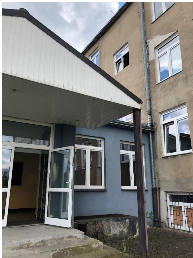
Ubytki tynku na elewacji skrzydła dydaktycznego oraz doświetlaczach betonowych
