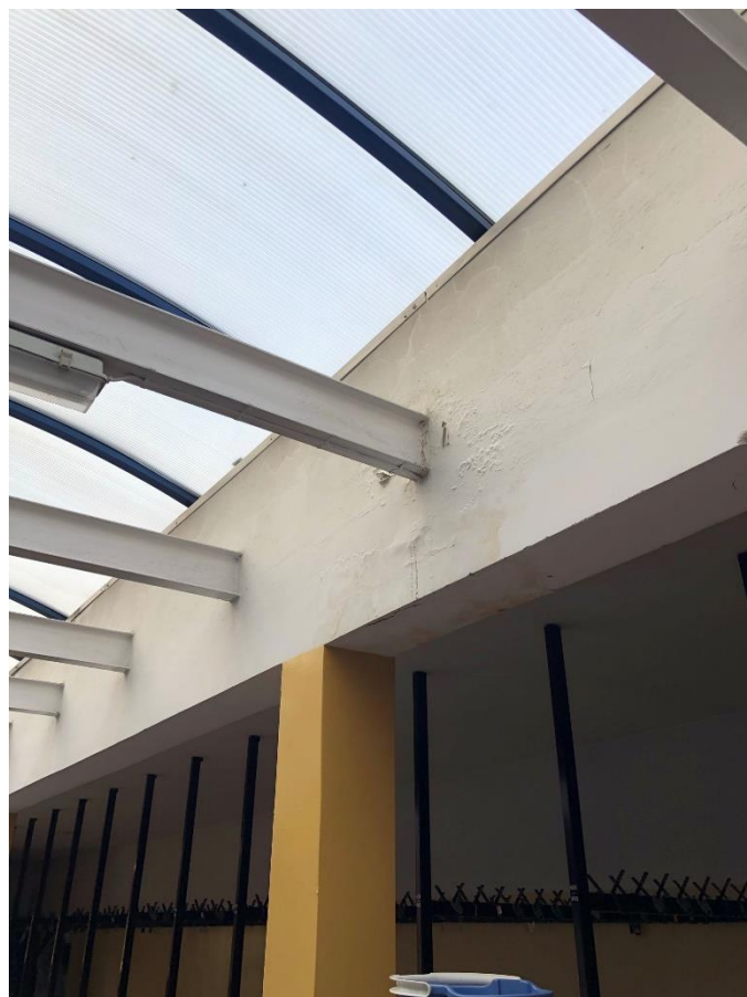
Ślady po zalaniach przy świetliku w szatni
