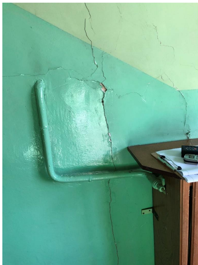
Spękania ściany klatki schodowej na II piętrze
