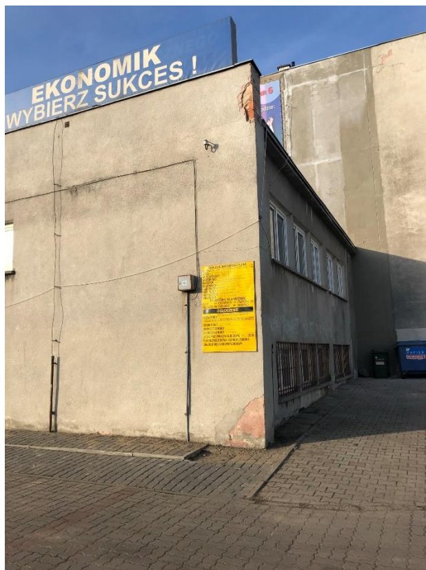
Ubytki tynku na elewacji skrzydła mieszkalnego
