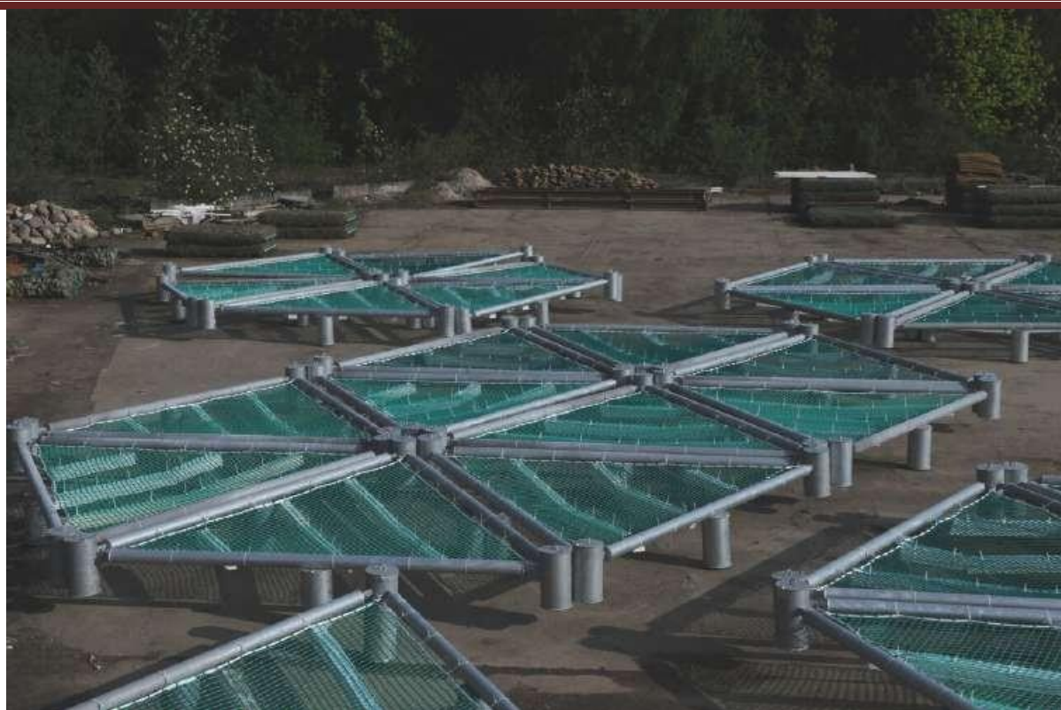
Fot. 2. Widok na przygotowane do instalacji mat wegetacyjnych elementy wysp pływających wg. systemu BESTMANN – technik
