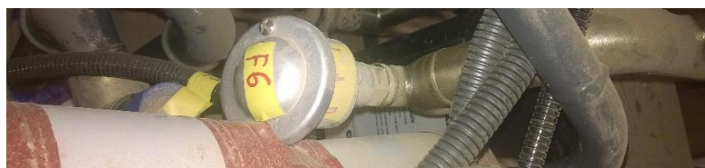
Zdjęcie nr_7 Nieakceptowalny sposób zabudowy czujnika temperatury.
