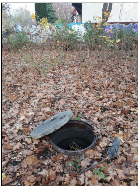
Zdjęcie 3A-3B. Teren badań – studzienka kanalizacyjna na czynnym przewodzie kanalizacji ściekowej (rejon punktu badawczego nr 3)
