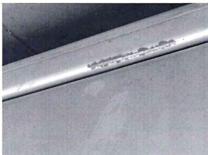
IMG_4479 - uszkodzenia elementów obłachowania
