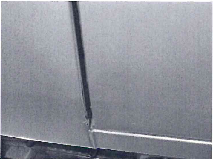
IMG_4505 - uszkodzenia elementów obłachowania
