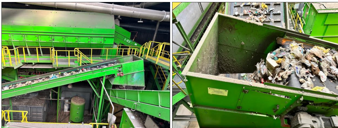
Zdjęcie 1 i 1'. Przesyp pomiędzy przenośnikami 02-04a i 02-05.
