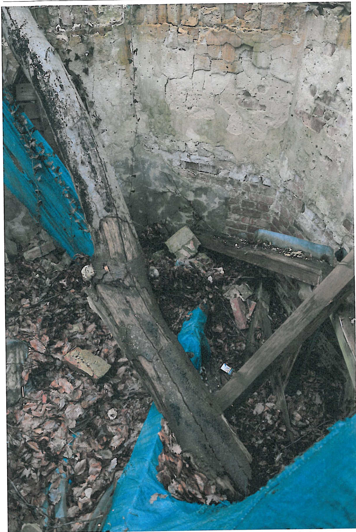
Fot. 12: Wnętrze budynku studni- zachowana konstrukcja murowa ścian i fragmenty tynku (zniszczonego i zawilgoconego); wyk.: 16.03.22
