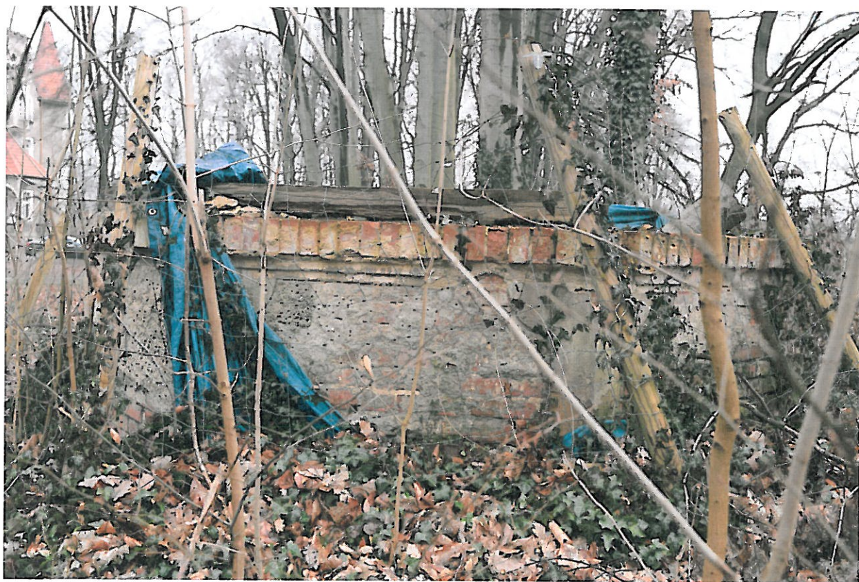
Fot. 11: Widok na południową ścianę budynku studni i zachowane fragmenty gzymsu, namurnicy i tynków zewnętrznych (dwa rodzaje faktury); wyk.: 16.03.22
