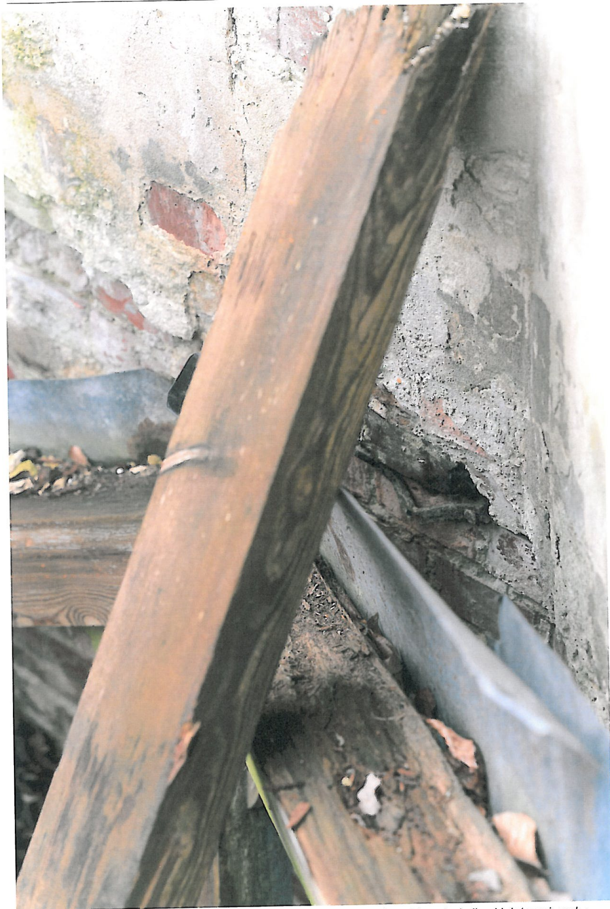
Fot. 14: Wnętrze budynku studni- zachowane fragmenty drewnianej konstrukcji szkieletowej; wyk.: 16.03.22
