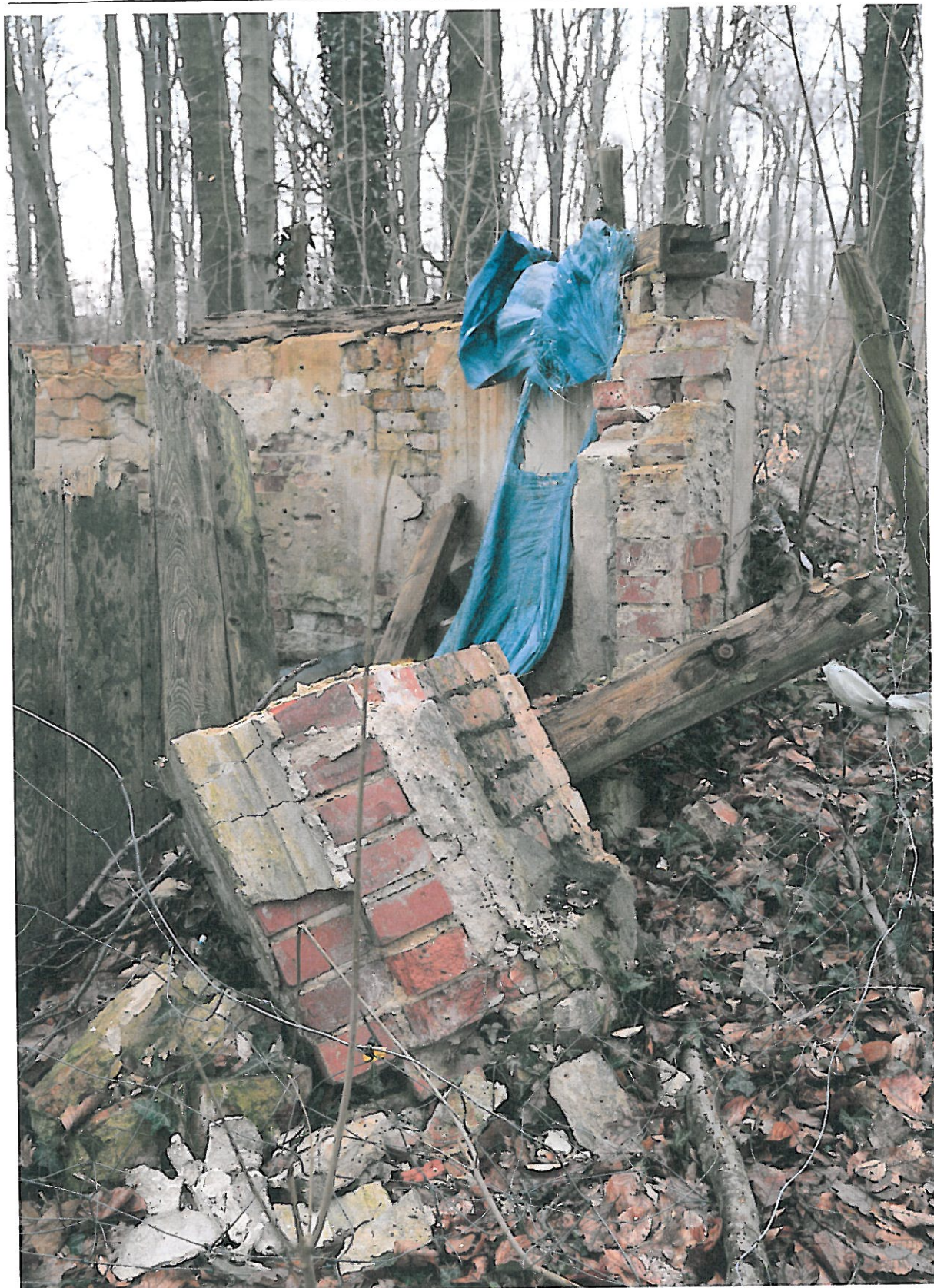
Fot. 9: Widok na uszkodzone drzwi wejściowe i fragment ściany; wyk.: 16.03.22
