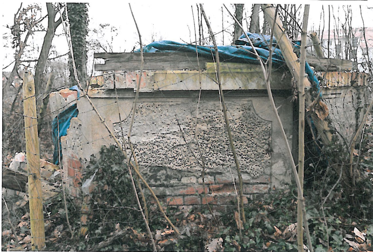
Fot. 10: Widok na południowo- zachodnią ścianę budynku studni i zachowane fragmenty gzymsu, namurnicy i tynków zewnętrznych (dwa rodzaje faktury); wyk.: 16.03.22
