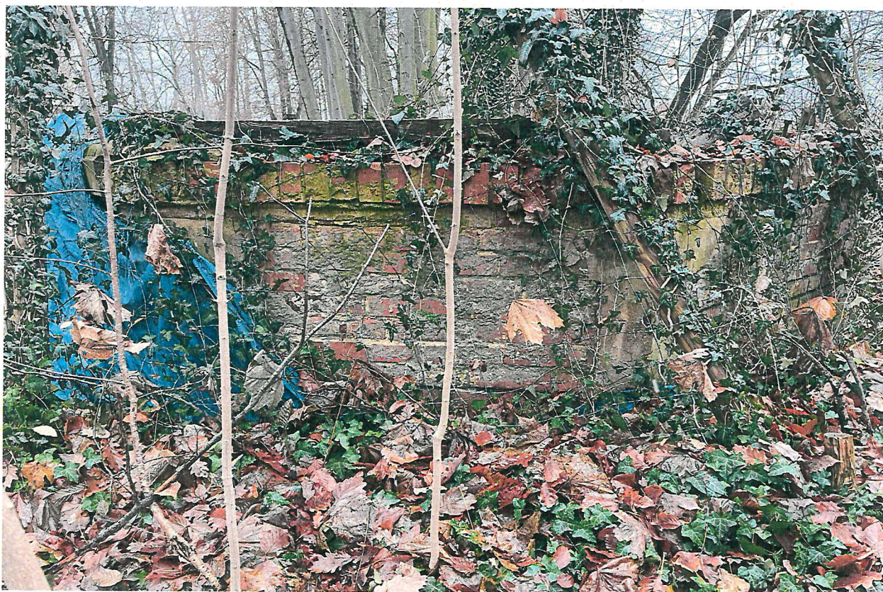
Fot. 9: Widok na południową ścianę budynku studni i zachowane fragmenty gzymsu, namurnicy i tynków zewnętrznych (dwa rodzaje faktury); wyk.: 12.12.24
