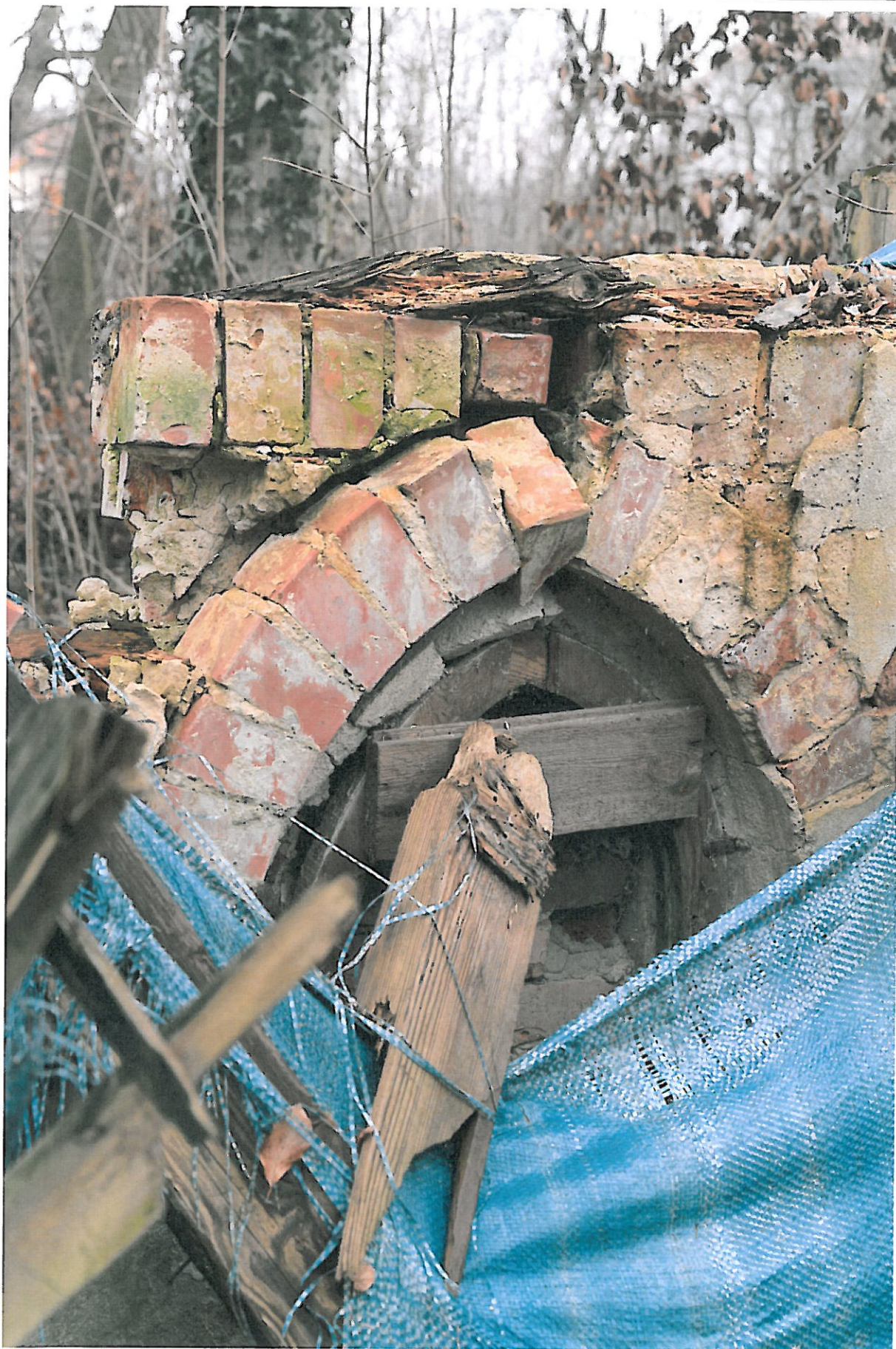
Fot. 13: Wnętrze budynku studni- zachowane fragmenty stolarki okiennej i nadproża; wyk.: 16.03.22
