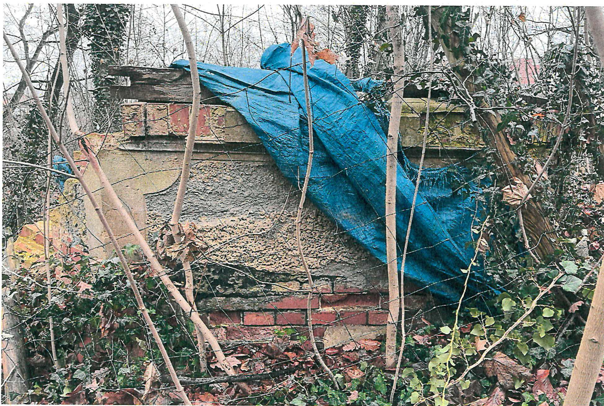
Fot. 8: Widok na południowo- zachodnią ścianę budynku studni i zachowane fragmenty gzymsu, namurnicy i tynków zewnętrznych (dwa rodzaje faktury); wyk.: 12.12.24
