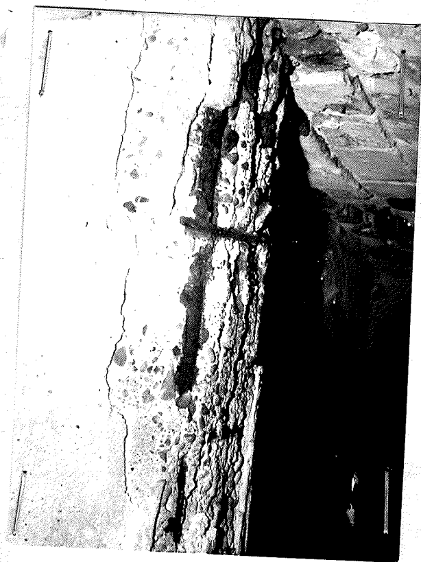
Zajęcia 11, 12. Skorodowane i rozsypujące się belki nośne żelbetowego stropu nad piwnicą. Konstrukcja stropu w stanie przedawaryjnym.
