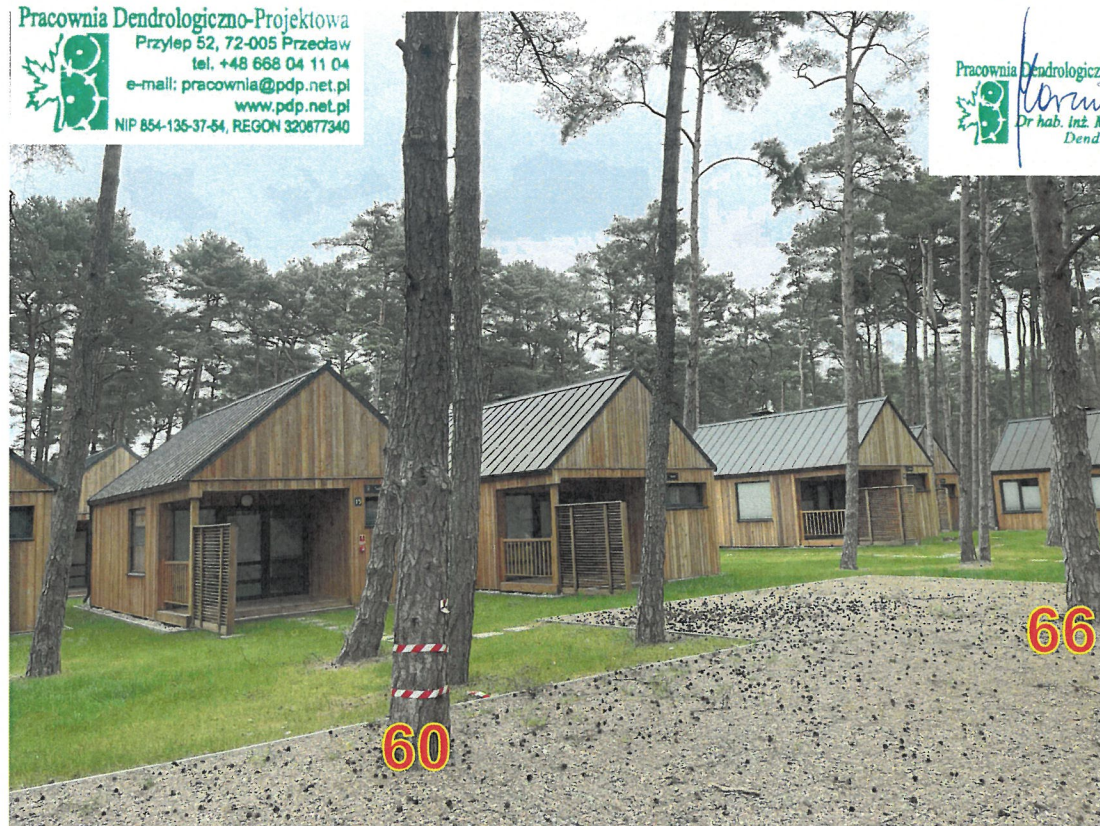
Fot. 3. Widok na parking z nawierzchnią z geokraty. Sosny nr 60 i 66 wymagające częściowego usunięcia geokraty i odsłonięcia części odziomkowych pni
