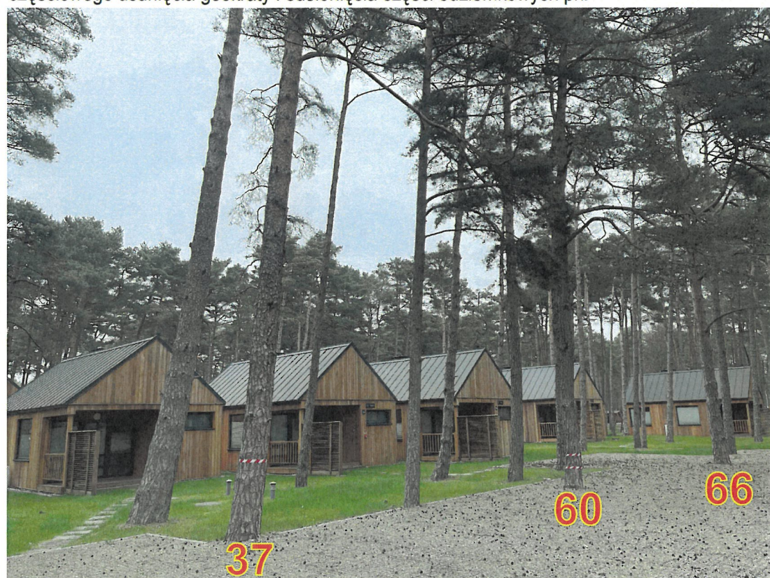
Fot. 4. Widok na parking z nawierzchnią z geokraty. Sosny nr 37, 60, 66 wymagające częściowego usunięcia geokraty i odsłonięcia części odziomkowych pni
