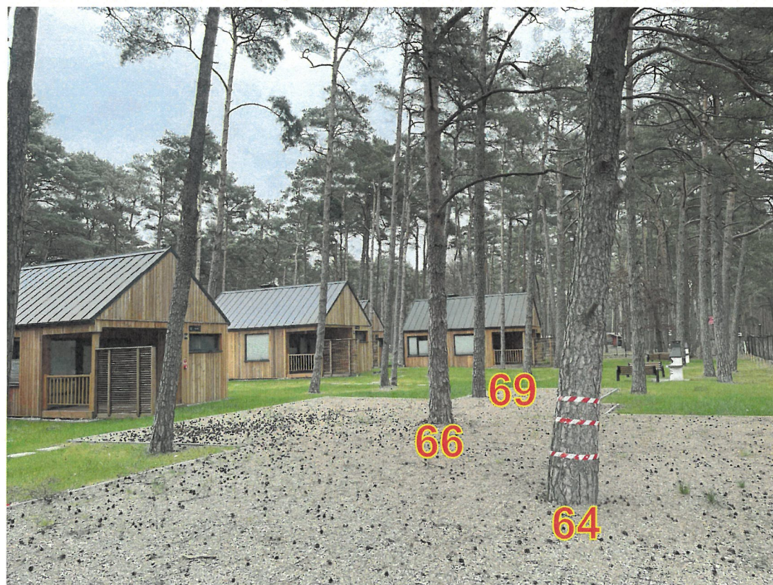
Fot. 2. Widok na parking z nawierzchnią z geokraty. Sosny nr 64, 66 i 69 wymagające częściowego usunięcia geokraty i odsłonięcia części odziomkowych pni
